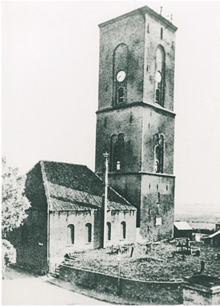
Frühere Ansicht des Alten Leuchtturms.
