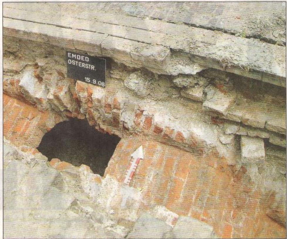
Emden, Osterstraße: Hier wurde der Brückenbogen der alten Osterpiepe angeschnitten.
